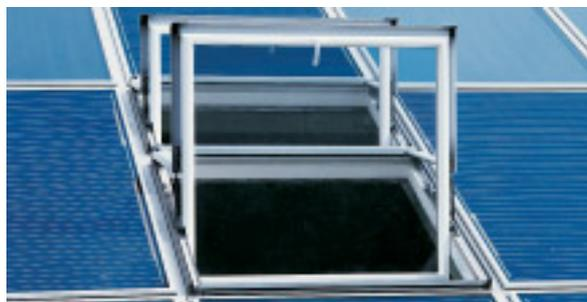
Les fenêtres entièrement basculées, en position permettant le nettoyage.
